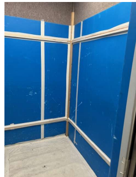
エレベーター内養生(例)
