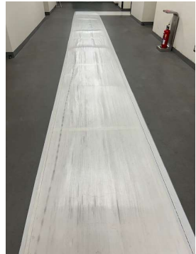
搬入通路養生(例)
